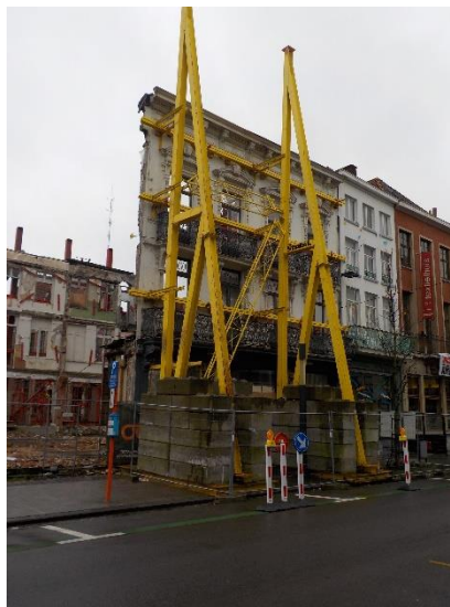
Figure 3: Exemple d'éтанçonnement de façade
